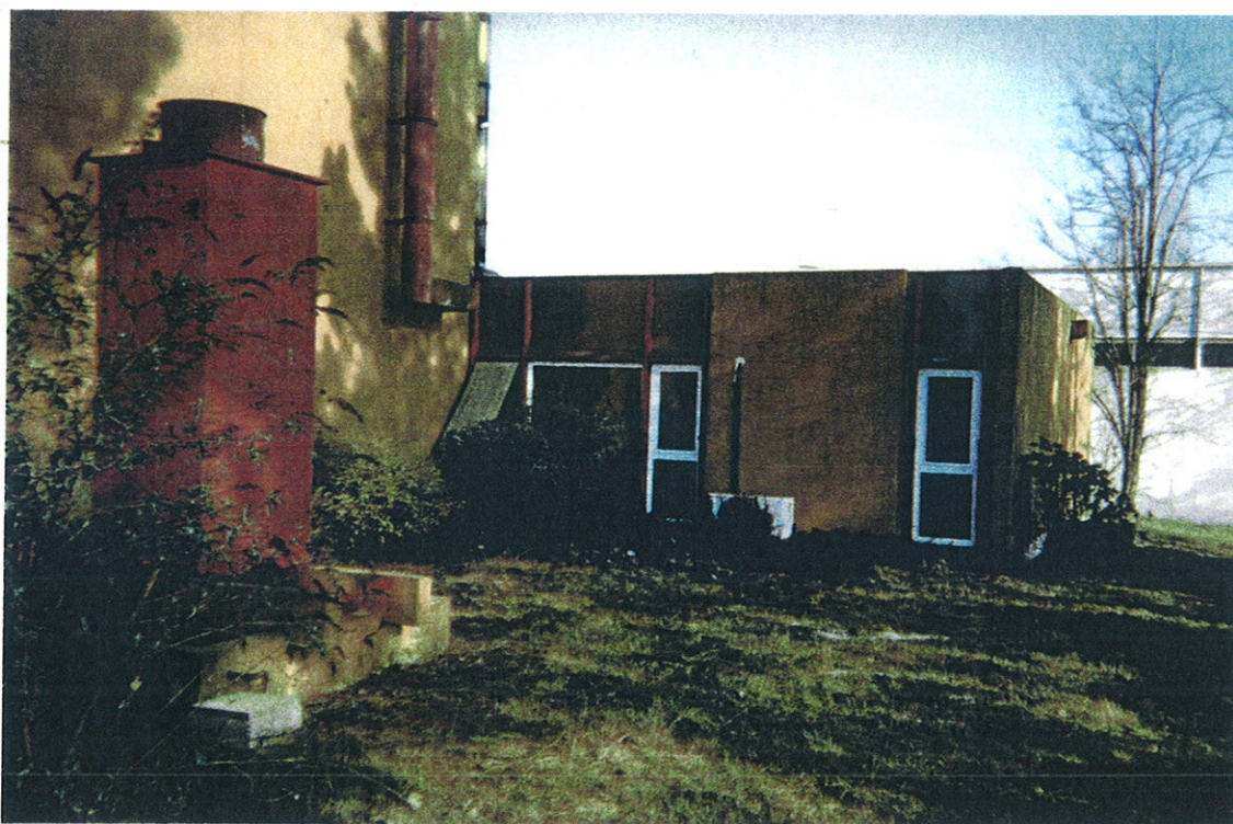
Figure n°7 : Vue des bureaux et de la tour de refroidissement.
